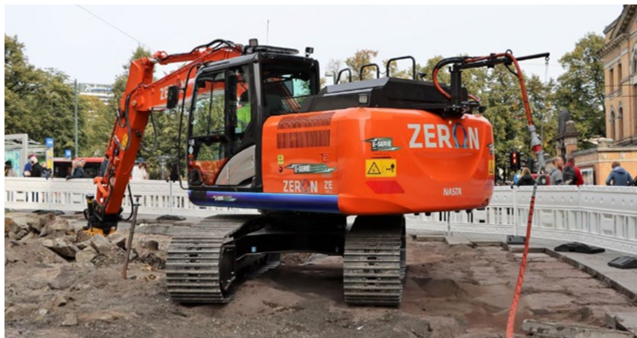
Anleggsmaskiner som enten er koblet til strømkabel mens de jobber eller drives på batteri skal bli vanlig i Oslo. Målet er at alle bygge- og anleggsplasser skal være utslippsfrie innen 2030. Foto: Ellen Omland
