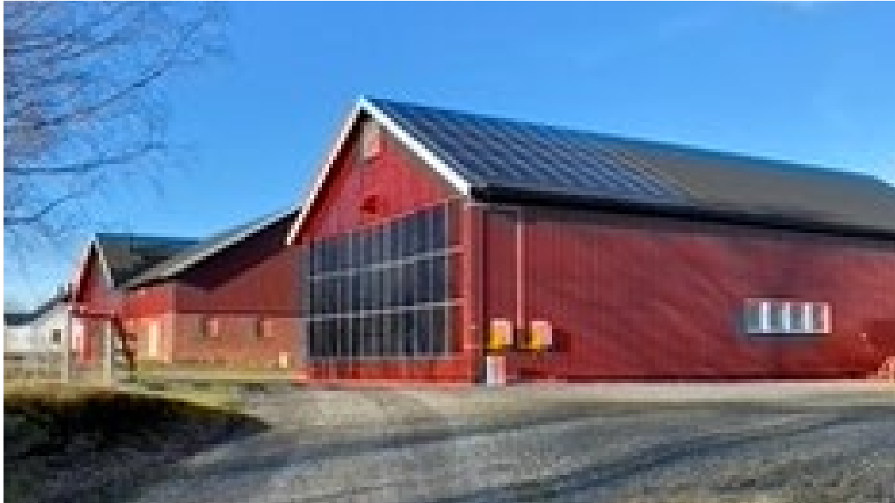
Solcelleanlegget på gården produserer 34 000 kilowatt strøm pr. år, i tillegg bidrar flisfyringsanlegget med hele 300.000 kilowatt Foto: Jens Petter Otterstad
