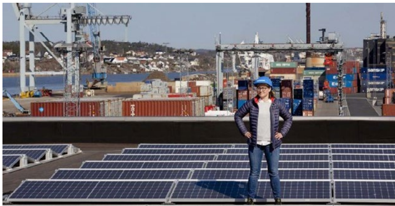
Miljøsjef Charlotte Iversen på taket til Lager 14 som bygges ut med solcellepaneler. Foto: vekstifredrikstad.no
