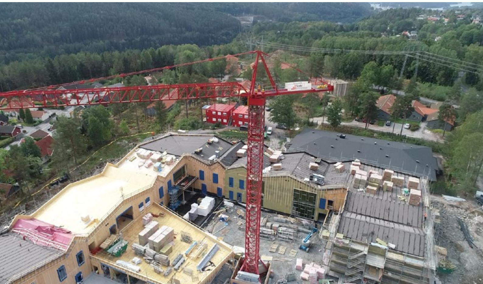
Bergheim bo og aktivitetssenter, Halden kommune, bygd i massivtre. Foto: Østfold fylkeskommune, Martin Norderhaug
