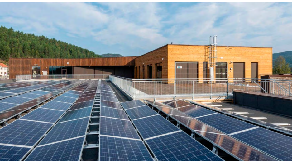
Vestsiden skole er bygget i massivtre og varmes opp av hydrogen. Foto: Kongsberg kommune
