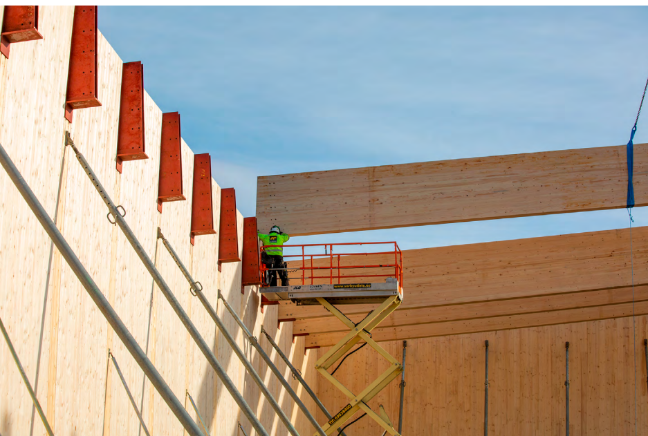
Knapstad idrettshall monteres på kort tid. Foto: Klima Østfold
