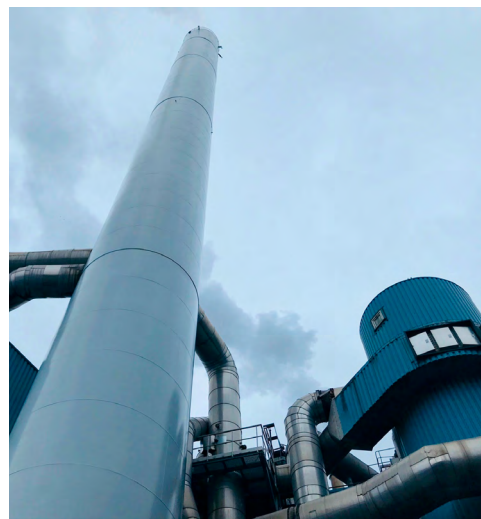
Klimautslippene ble 80 % lavere da Rockwool skiftet ut koks med strøm. Foto: Rockwool
