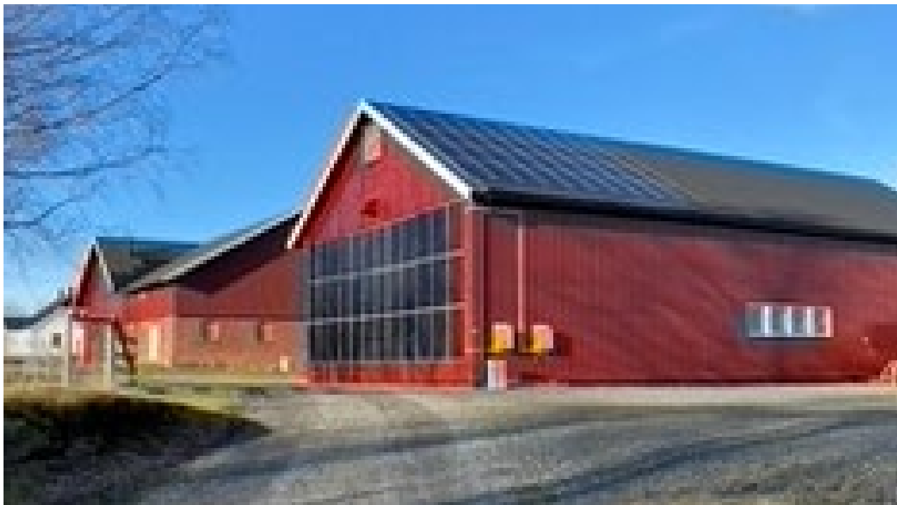
Solcelleanlegget på gården produserer 34 000 kilowatt strøm pr. år, i tillegg bidrar flisfyringsanlegget med hele 300.000 kilowatt Foto: Jens Petter Otterstad
