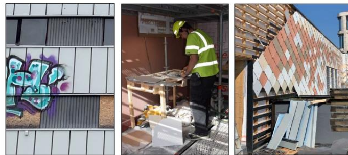
Foto fra befarig, Oppsal sykehjem. Foto: Randi Lunke Tilskjering og monteringsarbeid. Foto: Anne S Nordby Fasadeplater under montering. Foto: Randi Lunke
