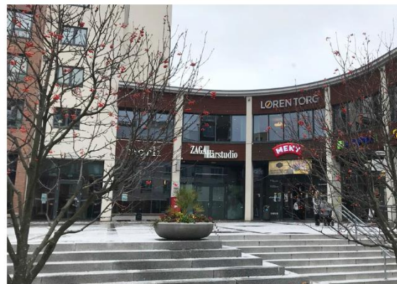
Løren torg - Handel og møteplass. Den lave delen slipper morgensolen inn på torget og ettermiddagssol inn i de private gårdsrommet bakerfor
