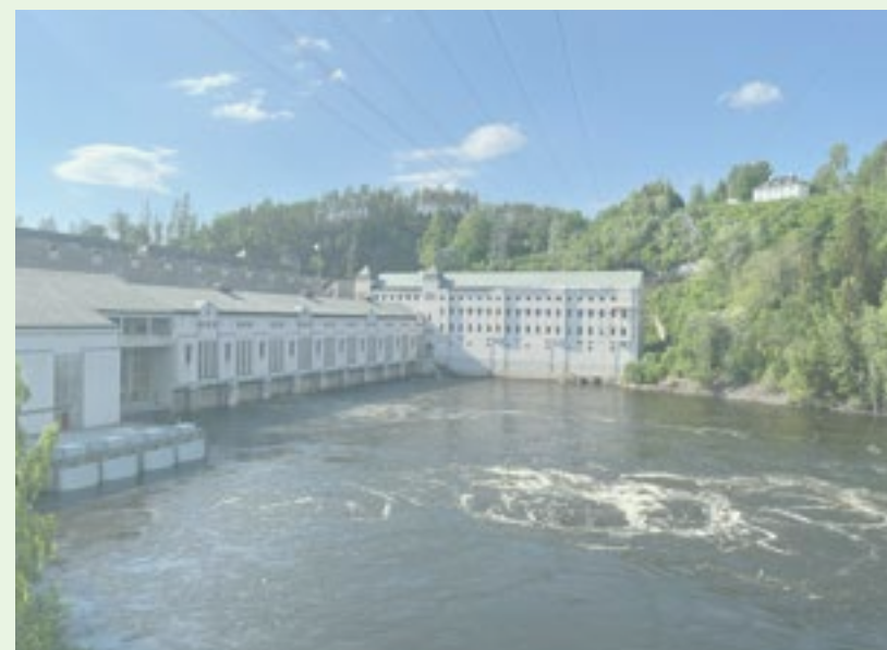
Vamma Kraftverk i Glomma i Indre Østfold og Skiptvet kommune i Østfold fylke. Osloregionen på besøk i forbindelse med felles faggruppesamling i mai 2024.
