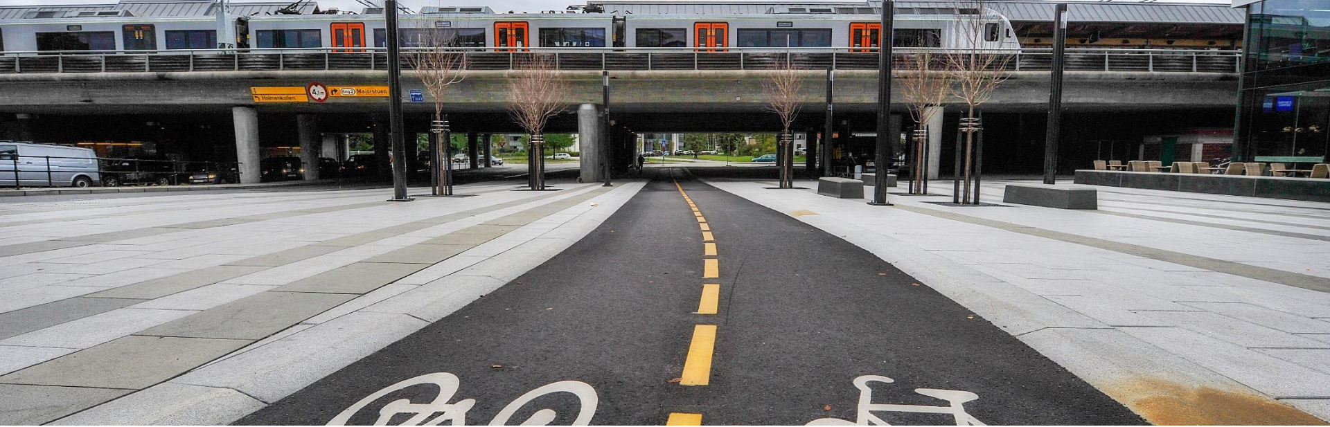
Foto: Knut Opeide, Statens vegvesen
