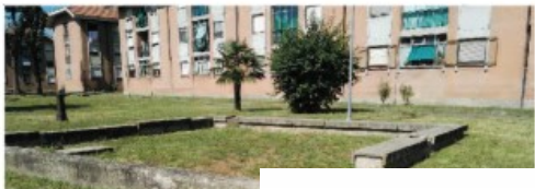
sedute in cemento
