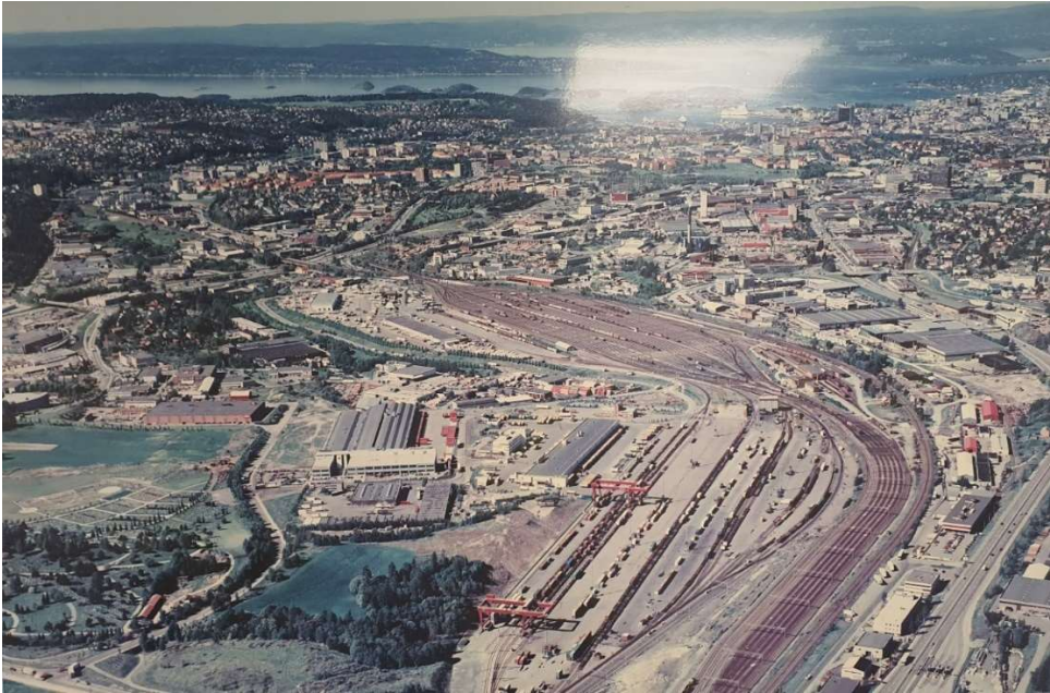
Figur 4-12: Oversiktsbilde fra Alnabru-terminalen på 1980-tallet. Med unntak av nye terminaler er det lite utvikling på sporområdet, ifølge CargoNet. Foto: CargoNet
