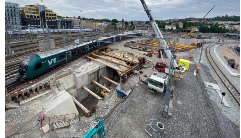
Arbeidene på Oslo S , som vil gi flere gjennomgående tog i Oslotunnelen fra Follobanen og Østfoldbanen , fullføres i løpet av 2023
